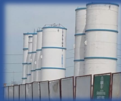
ใช้ Polymer เป็นสารละลายพยุ้งดิน
