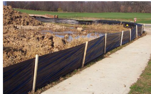
รั้วดักตะกอนชั่วคราวแบบ Temporary Silt Fence
