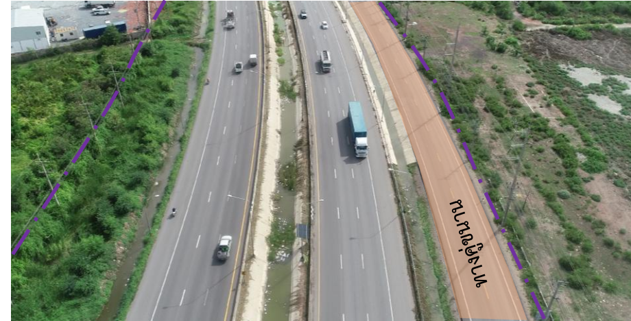
ถนนช่องจราจรทางหลักและมีทางคู่ขนานด้านเดียว
