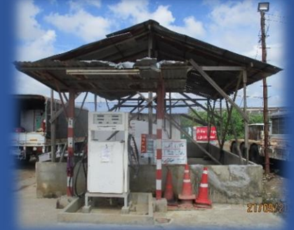
เทพื้นคอนกรีตยกขอบ บริเวณที่เก็บน้ำมัน
