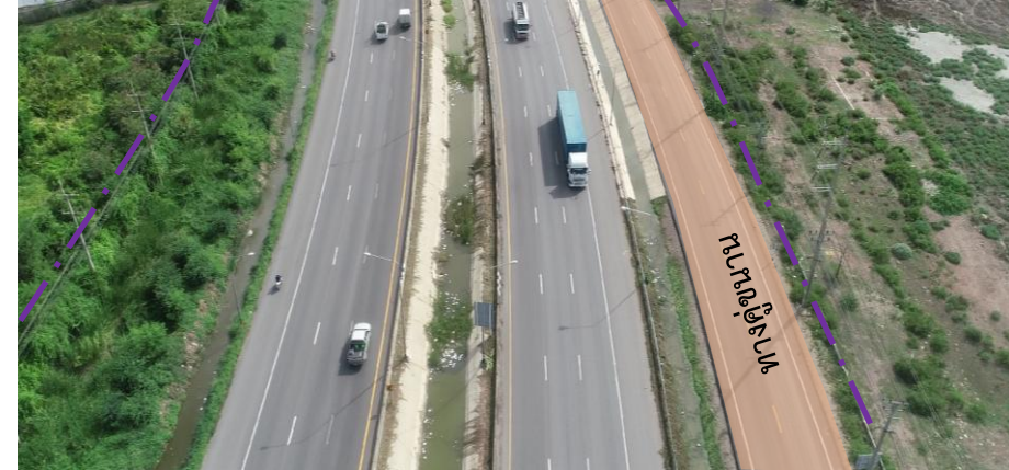
ถนนช่องจราจรทางหลักและ มีทางคู่ขนานด้านเดียว
